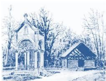
Commune de Sainte-Montaine - 18700
